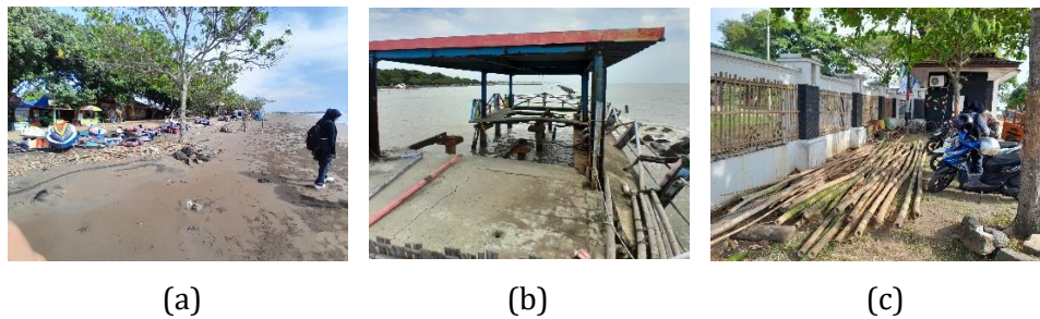
Gambar 6. (a)Keadaan Bibir Pantai (b) bangunan rusak (c) parkir
